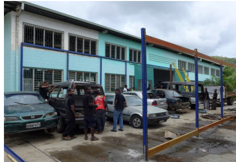
Schon stehen die Stützen für das Vordach bei der Automobilwerkstatt.
